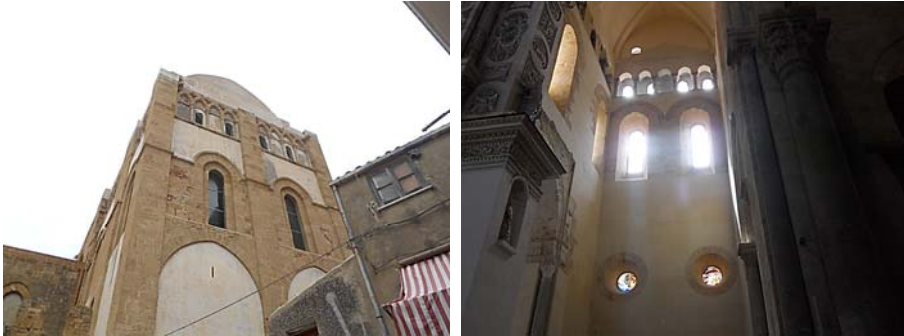
Fig. 4. Le aperture dell'ala meridionale del transetto osservate dall'esterno e dall'interno (Foto: Tuscano M.L.).
