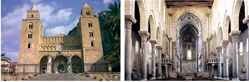
Fig. 2. Prospetto occidentale del Duomo di Cefalù e accanto navata centrale con l'abside in cui è rappresentato il Cristo Pantocratore, icona dell'Anno della fede.
